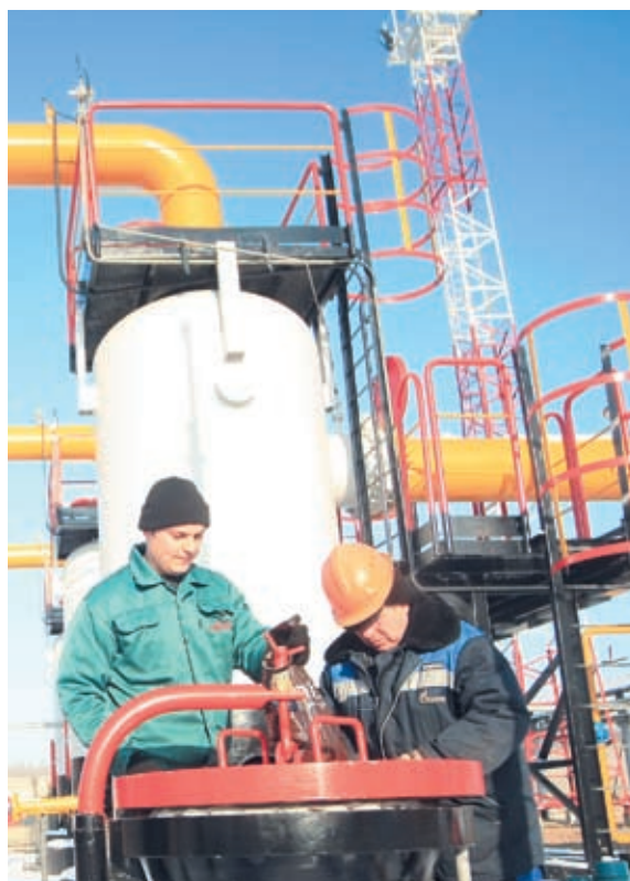
Работы на КС «Володино» продолжаются и в выходные дни. Монтаж оборудования
